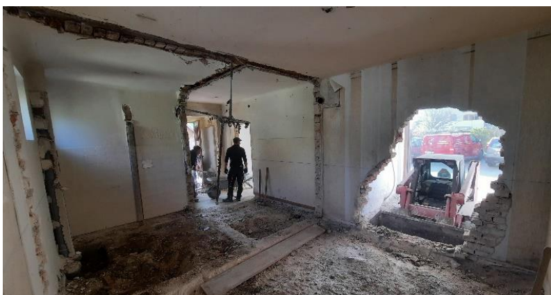
Erste Bauarbeiten im Amtsgebäude, fast alle Zwischenwände wurden entfernt und der Durchbruch für den neuen Eingang erstellt.
