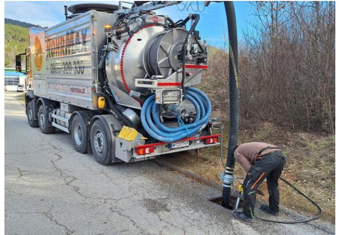
Neben der **Frühjahrskehrung** gehören auch die Reinigungsarbeiten unserer **Straßenentwässerungsanlagen** zu den Routinearbeiten an unseren Wegen und Straßen. Schächte, Gitter und Verrohrungen werden überprüft und wenn erforderlich gereinigt, um bei Starkniederschlägen die rasche Wasserabführung gewährleisten zu können.
